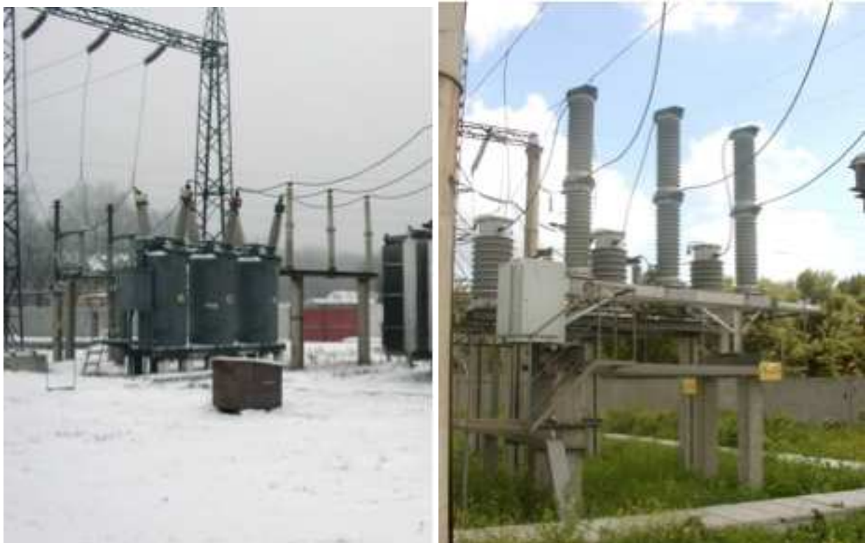
Малюнок 3. Автоматичні вимикачі до та після проведення реконструкції.
