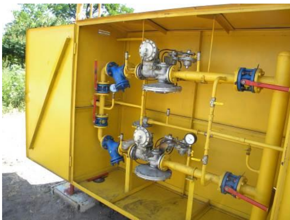
Рис. 2. Відремонтване ШРП в с. Красноармійське, реєстровий № 104.
