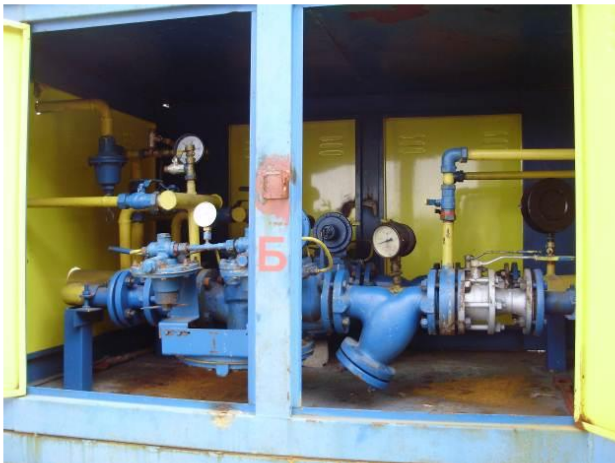
Рис. 1. Відремонтване ШРП в с. Кас'янівка, реєстровий № 53.
