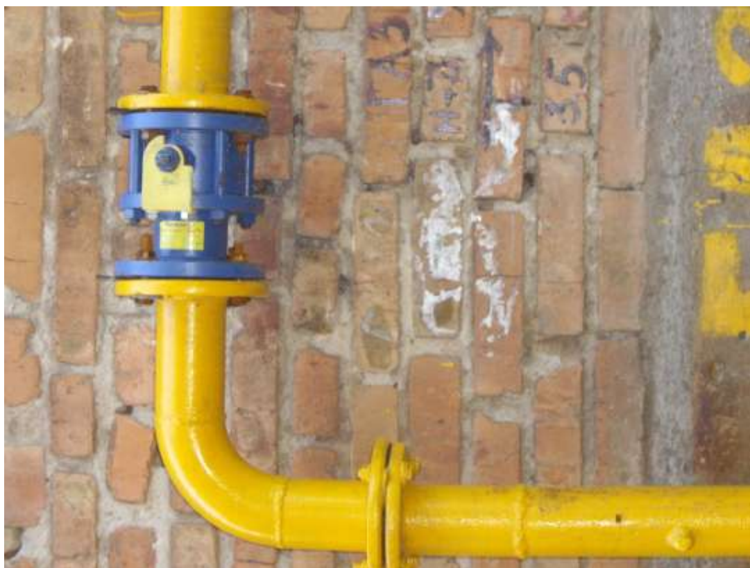
Рис. 1. Відремонтована засувка, м. Кривий Ріг
