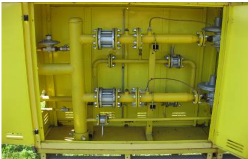
Рис. 1. Відремонтоване ШРП, м. Лубни
