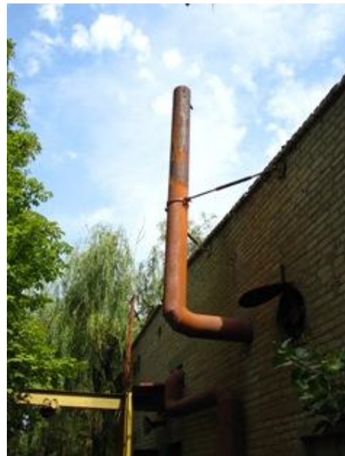
Рис. 5 Свіча (без факелу) станції дегазації, через яку шахтний метан викидається в атмосферу без спалювання
