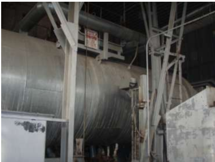
Рис. 1. Котел – утилізатор.
