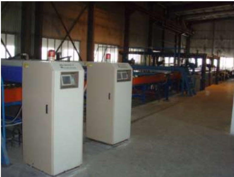
Рис. 4. Обладнання контролю якості скла.
