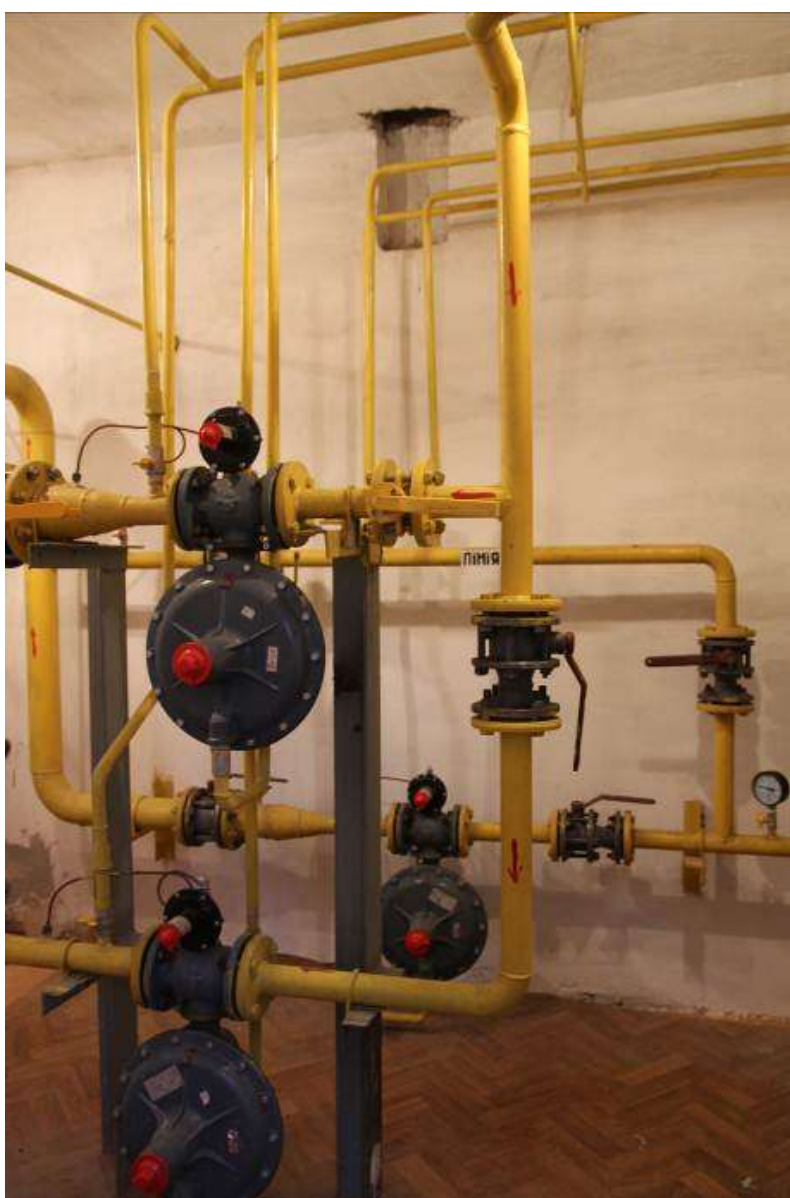
Рис. 1. Відремонтований ГРП, м. Полтава, вул. Гожулянська, 28, реєстровий № 458
