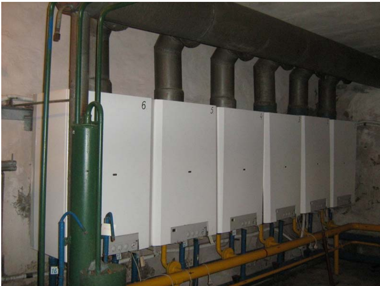
Рис. 1. Реконструкція котельні із встановленням модульних котлів
