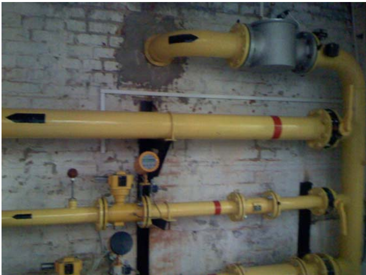
Рис. 2. Газо-розподільний пункт.
